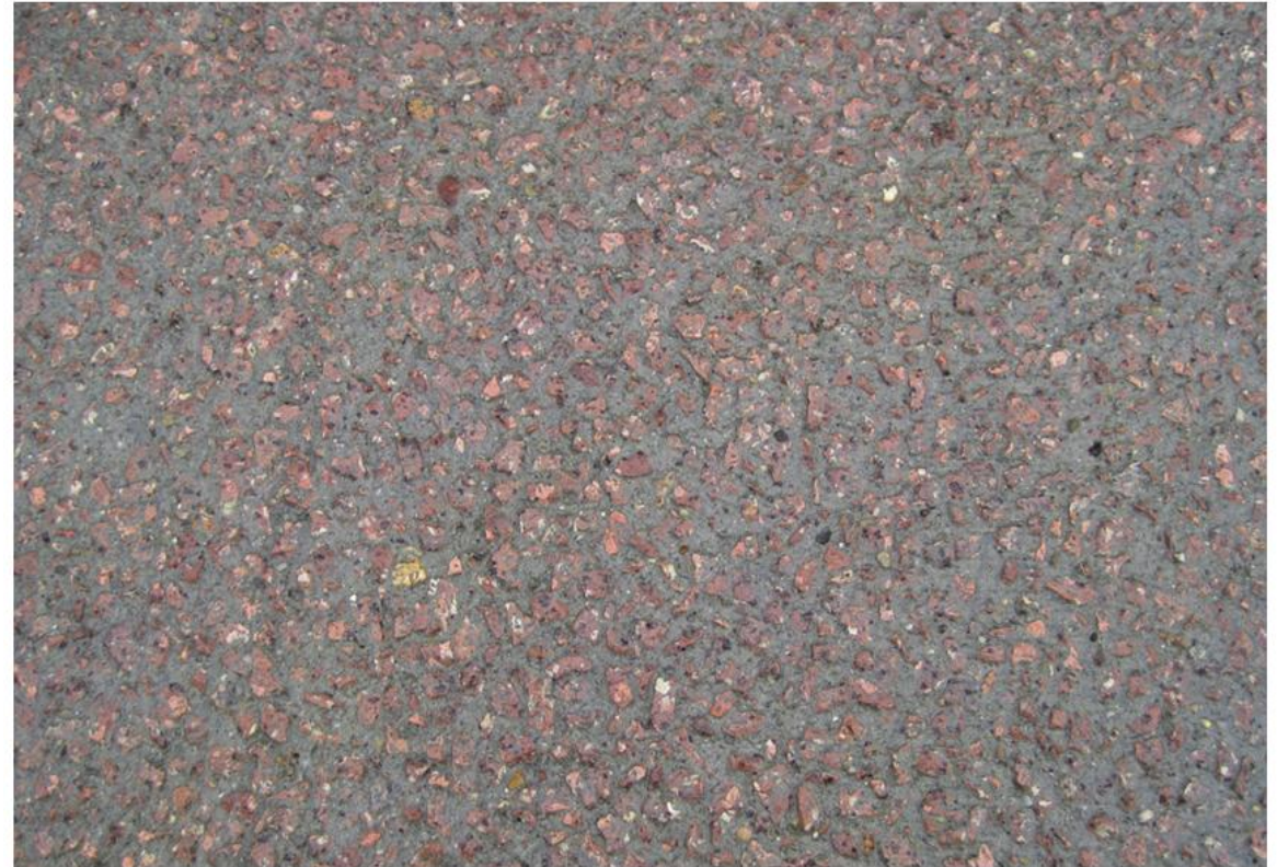
Bild 11: Oberfläche nach dem Hochdruckwasserstrahlen
