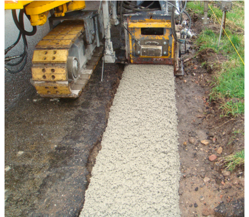
Hollandada "Bermcrete" inşaatı © Heijmans
