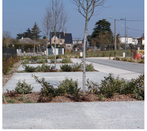
Geçirimli beton kaplamalı otopark, Dreux (Fransa) © CIMbeton
