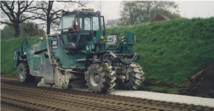
Çimento ile toprak stabilizasyonu
