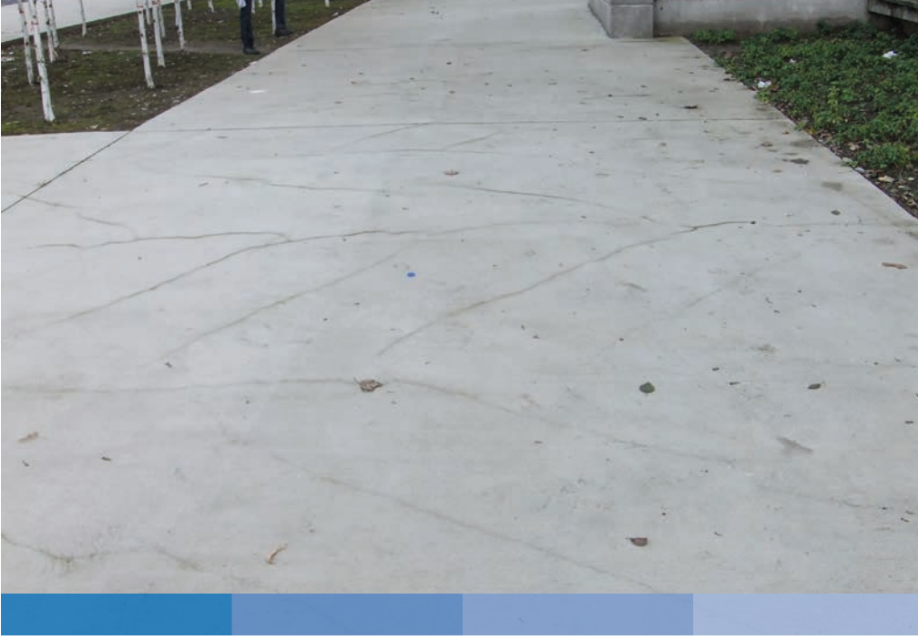
Taze betonun yeterince korunmamasından kaynaklanan rastgele rötre çatlakları
