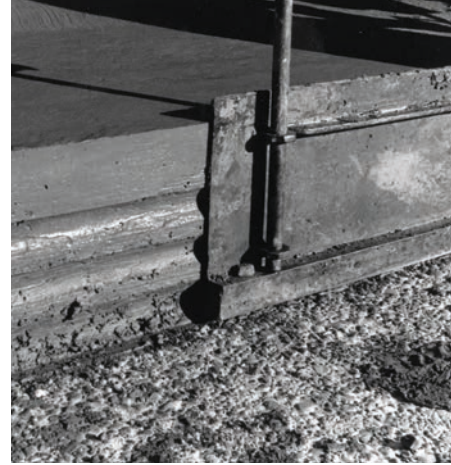
Zıvanalı ve sinüs profilli boyuna derzler (tavsiye edilmeyen uygulama)
