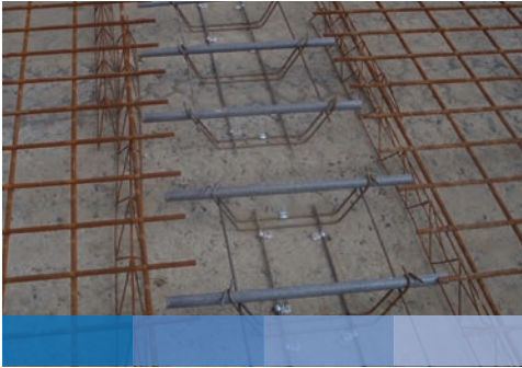
Birleştirilen çelik hasırlar ve kayma demirleri
