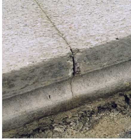
Zıvanalı ve sinüs profilli boyuna derzler (tavsiye edilmeyen uygulama)
