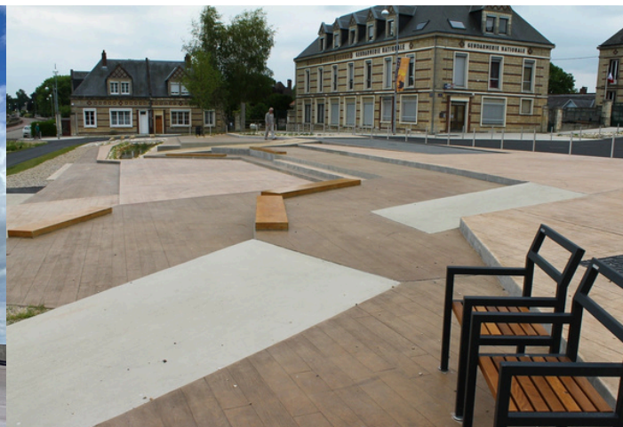
© Bord de Seine - Cimbéton
