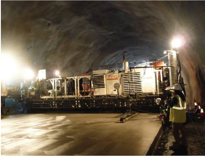
Şekil 19: Tam genişlikte yol kaplaması
