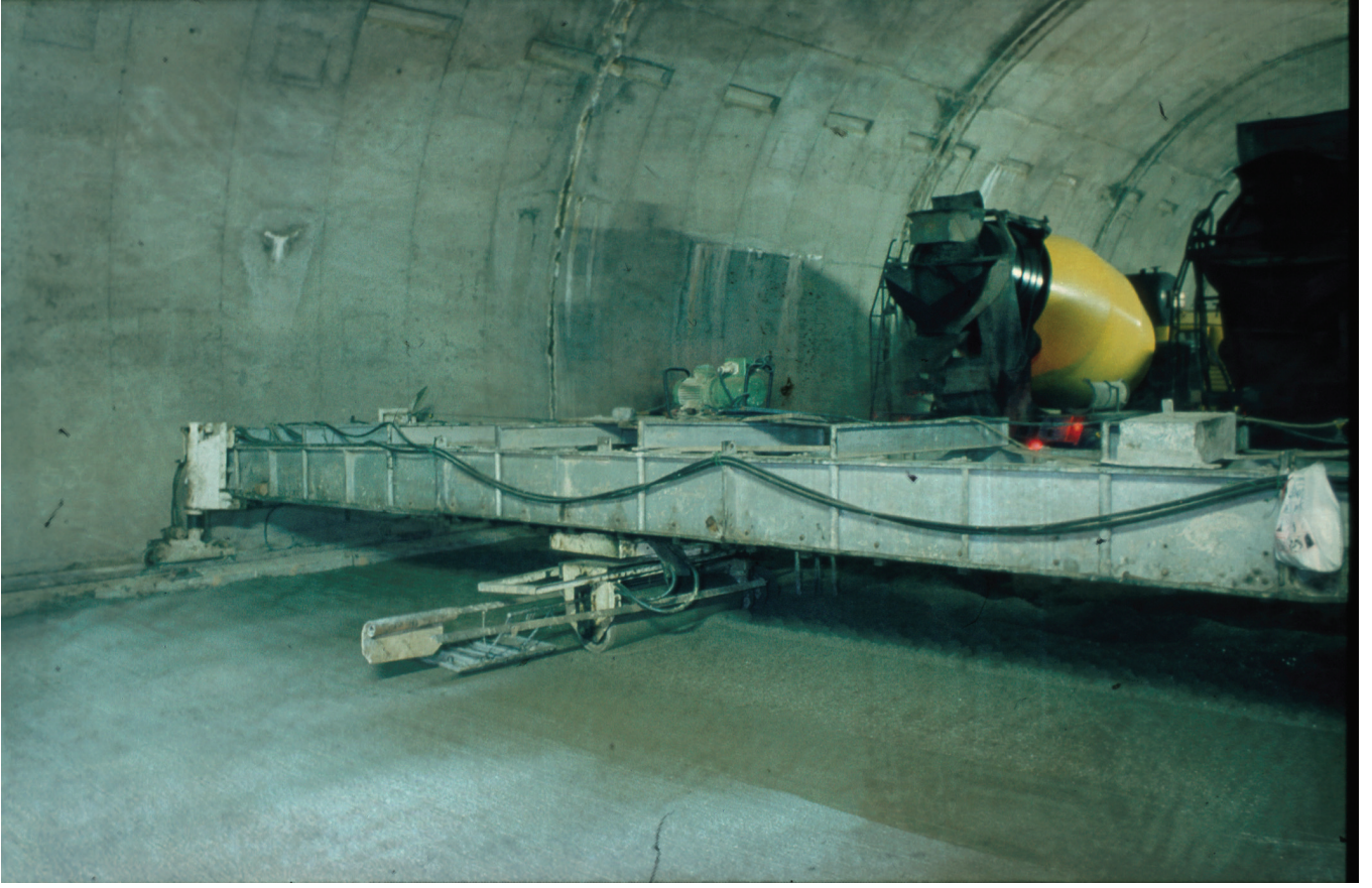
Şekil 17: Silindir finişer
