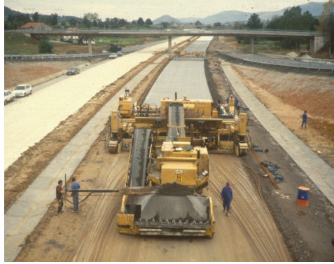
Şekil 25: Sürekli donatılı beton yol kaplamasında, mekanik çelik döşemesi
