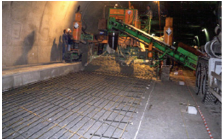
Şekil 24: Yarı genişlikte sürekli donatılı beton yol kaplaması
