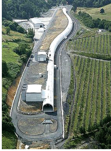
Şekil 2: San Pedro de Anes (İspanya)'de Tünel Havalandırma ve Yangın Deneyleeri Merkezi'nde bulunan deney tüneli
