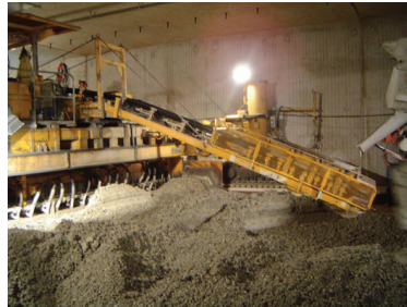
Şekil 22: İki tabakalı kaplamalarda, üst tabaka beton temininin sağlanması
