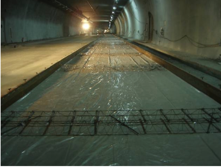
Şekil 18: Yarı genişlikte yol kaplaması
