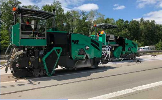
Tařlama makinesi alıřır durumda ve son derece dyk grltl "Yeni Nesil Beton Yzey"
