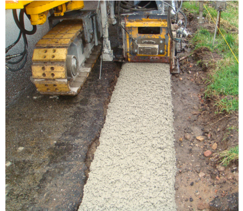
Hollanda'da 'Bermcrete' yapımı © Heijmans
